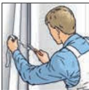
**6.** Dans les coins et sur les arêtes, ne pas effectuer de chevauchement. La séparation se fait exactement sur l'arête. Tapiser les deux lés bord à bord à joints vifs.
